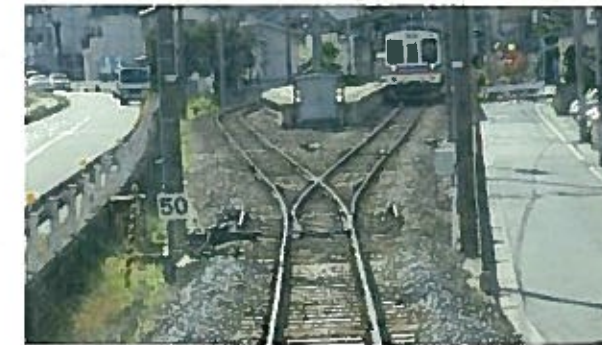
図 2-3 行き違い設備の例 (三滝駅)
